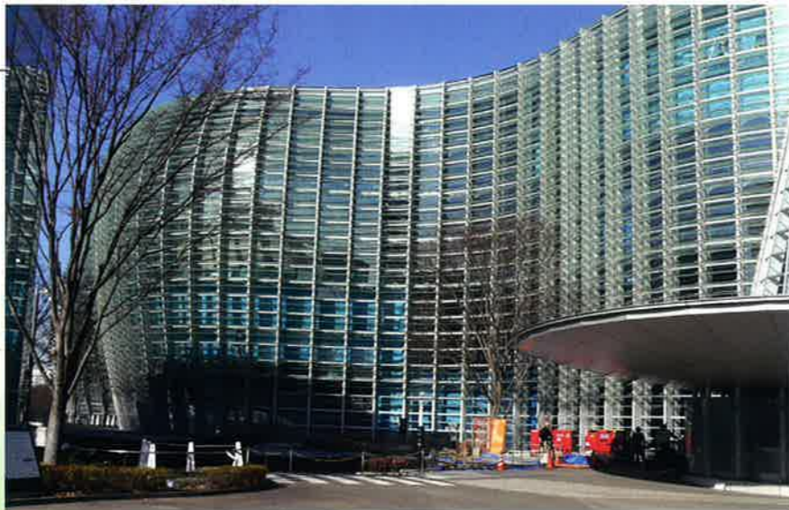
● 国立新美術館 施工完了
