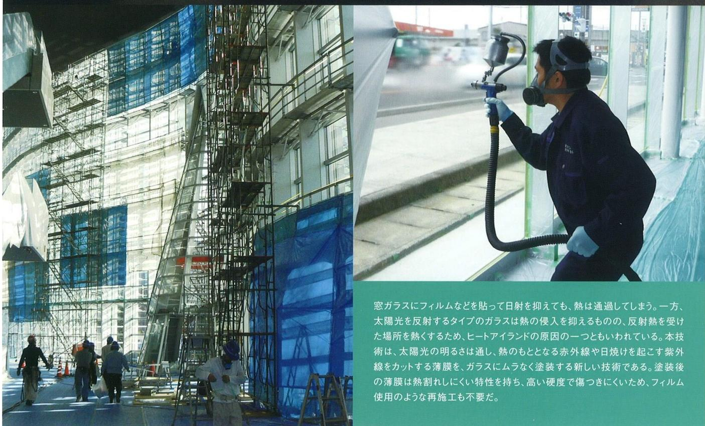
窓ガラスにフィルムなどを貼って日射を抑えても、熱は通過してしまう。一方、太陽光を反射するタイプのガラスは熱の侵入を抑えるものの、反射熱を受けた場所を熱くするため、ヒートアイランドの原因の一つともいわれている。本技術は、太陽光の明るさは通し、熱のもととなる赤外線や日焼けを起こす紫外線をカットする薄膜を、ガラスにムラなく塗装する新しい技術である。塗装後の薄膜は熱割れしにくい特性を持ち、高い硬度で傷つきにくいいため、フィルム使用のような再施工も不要だ。
