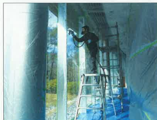
専用のスプレーガンによる塗布の様子
