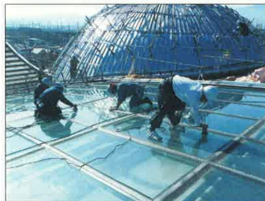
こむこむ館（設計：NTTファシリティーズ）のトップライトへのフミンコーティングの施工風景
