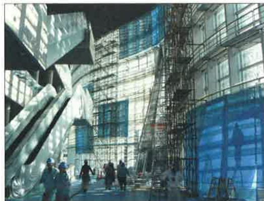
国立新美術館のガラスカーテンウォールへのフミンコーティングの施工風景
