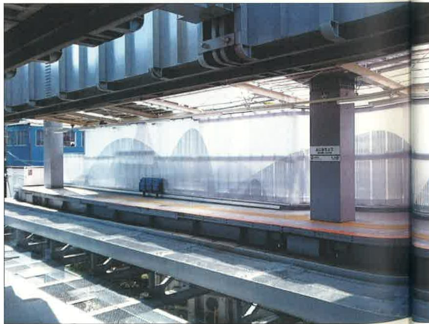
湘南モノレール富士見町駅改修 (設計：鎌倉藤沢リング・プロジェクト研究会)
