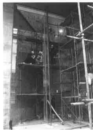
写真4 縦8メートルの超大型ガラス40枚施工
