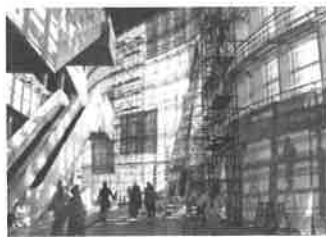
写真2 国立新美術館コーティング施工風景
