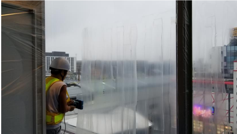
清掃作業(コンパウンドにて汚れ、油脂除去)
