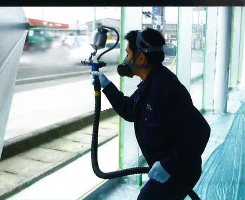
窓ガラスにフィルムなどを貼って日射を抑えても、熱は通過してしまう。一方、太陽光を反射するタイプのガラスは熱の侵入を抑えるものの、反射熱を受けた場所を熱くするため、ヒートアイランドの原因の一つともいわれている。本技術は、太陽光の明るさは通し、熱のもととなる赤外線や日焼けを起こす紫外線をカットする薄膜を、ガラスにムラなく塗装する新しい技術である。塗装後の薄膜は熱割れしにくい特性を持ち、高い硬度で傷つきにくいため、フィルム使用のような再施工も不要だ。
